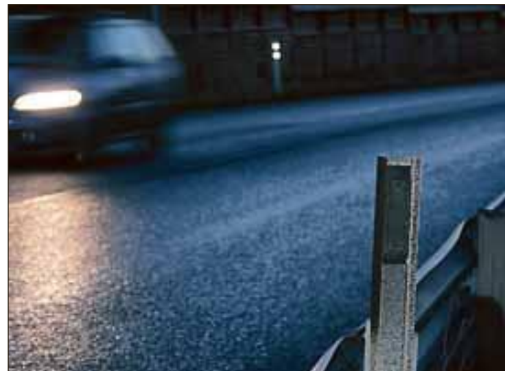
OVERGRODD: Salten legger seg i tykke lag på refleksstolper langs veien, og blender dem. Her et bilde fra E6. Stolpen på høyreside er «mørklagt», mens den i motgående kjøretning lyser som den skal.
